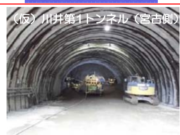
⑬施工：西松建設
