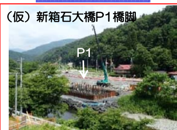
⑱施工：安藤・間
