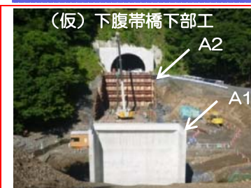
⑧施工：戸田・岩田地崎JV
