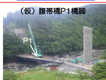
⑪施工：大豊建設
